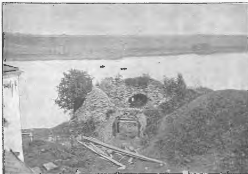
Рис. 18. Входъ въ Роскатную башню со стороны двора.
