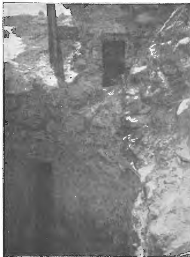
Рис. 20. Входъ и выходъ соединительной лѣстницы.
