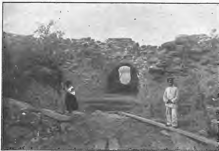
Рис. 10 Входъ въ Стрѣлочную башню со стороны двора.
