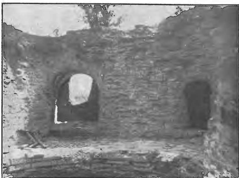
Рис. 21. Верхний этаж Климентовской башни, съ внутренней стороны.
