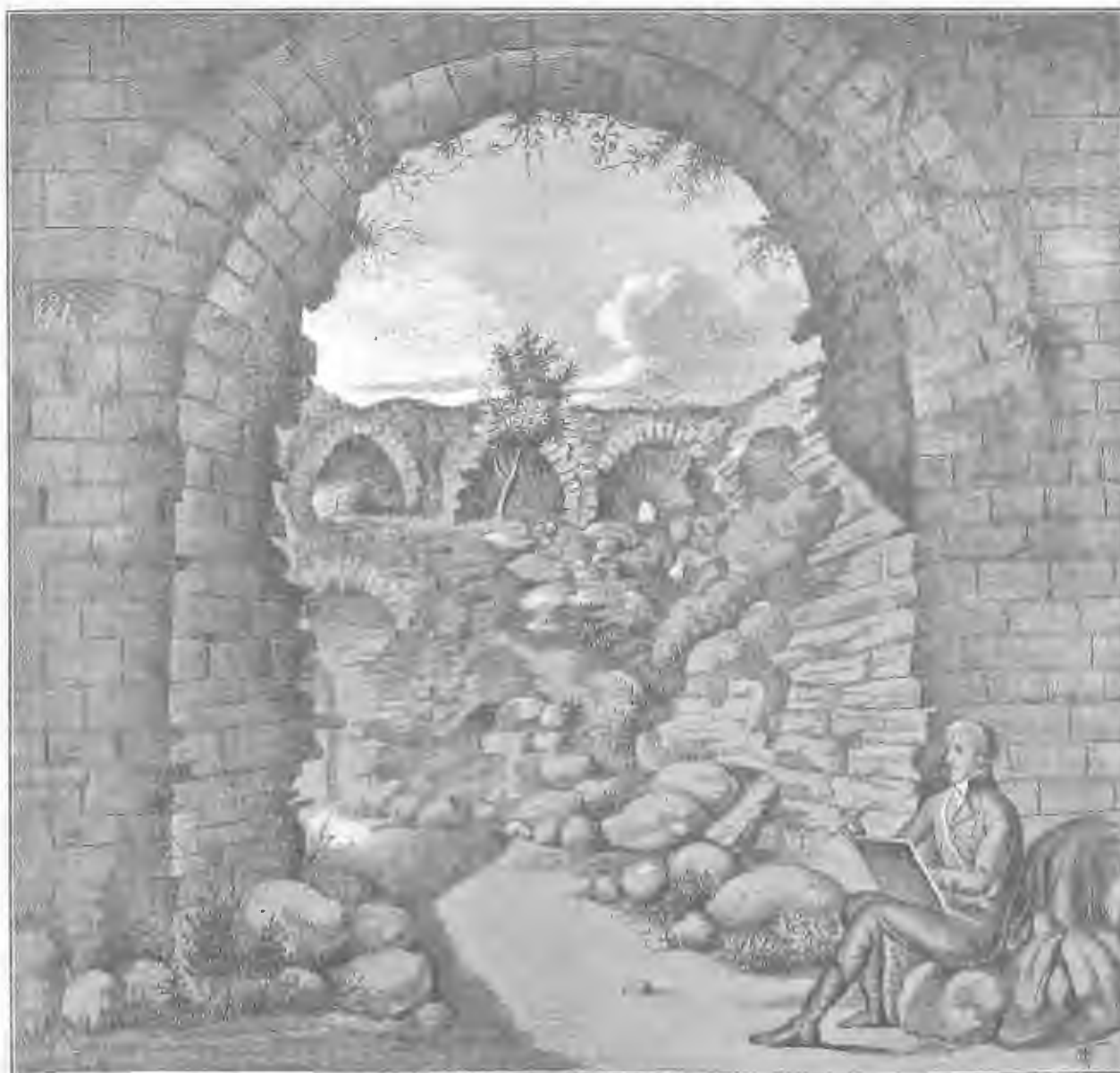
Рис. 6. Видъ внутренней проѣздной арки Воротной башни въ 1809 г., съ восточной стороны.
