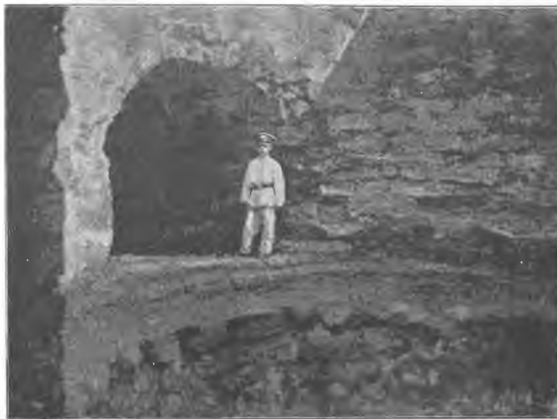
Рис. 23. Подполье и западная амбразура нижняго этажа Климентовской башни.
